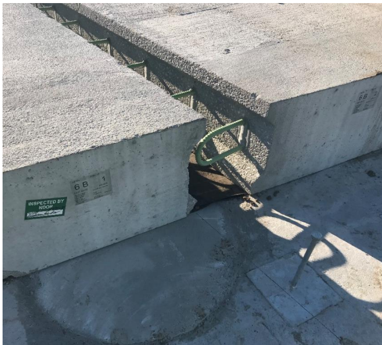
Longitudinal Joints
