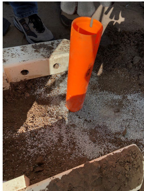
(d) final view of the installed casing
